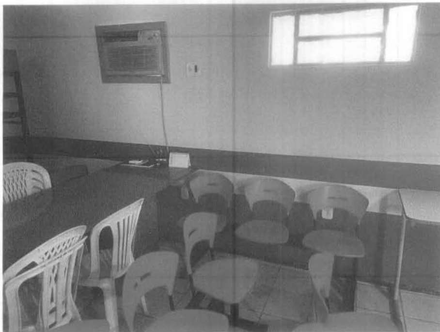
Imagem 9 – Pintura interna do prédio.
