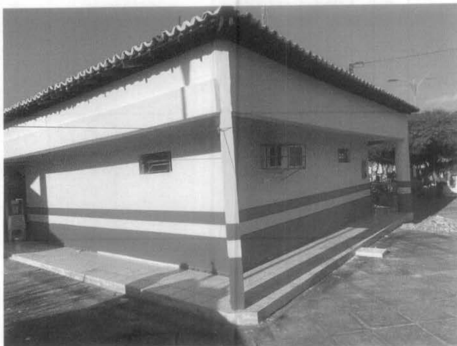
Imagem 3 – Pintura da fachada do prédio.
