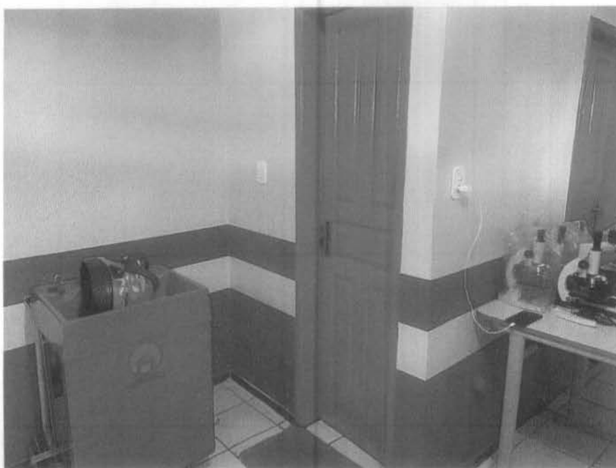
Imagem 8 – Pintura interna do prédio.
