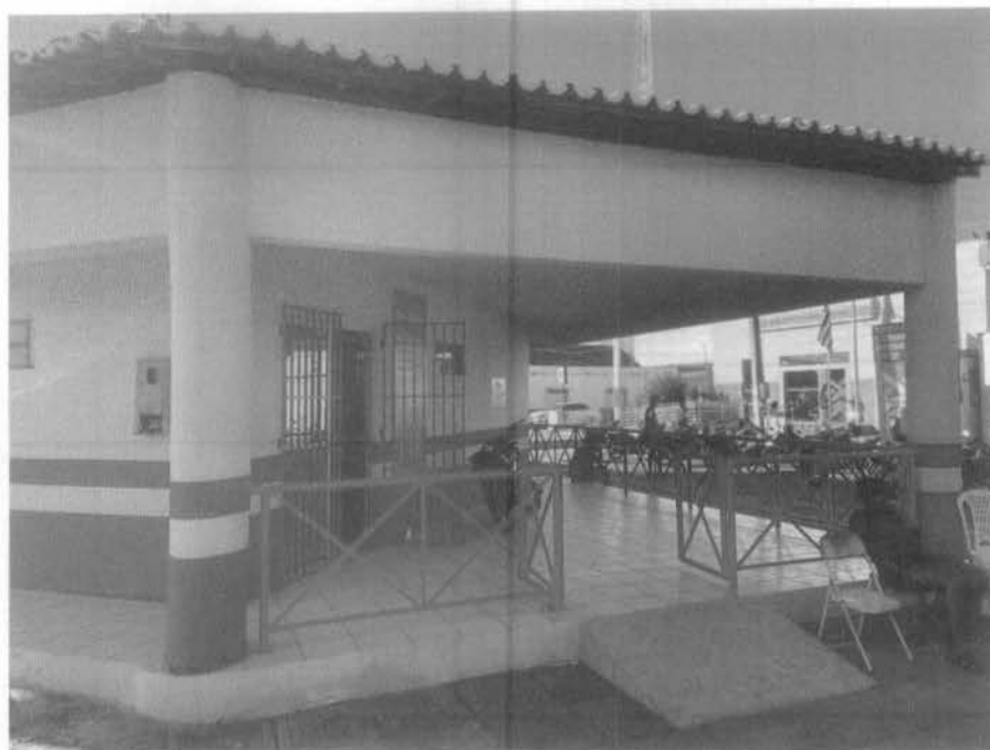
Imagem 1 – Pintura da fachada do prédio.
