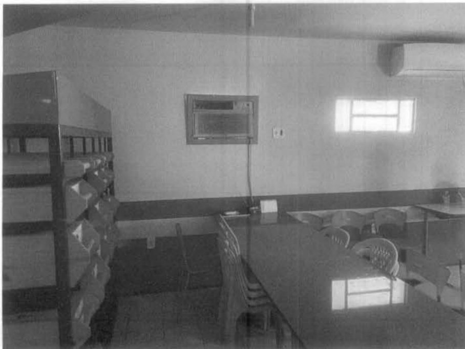
Imagem 10 – Pintura interna do prédio.
