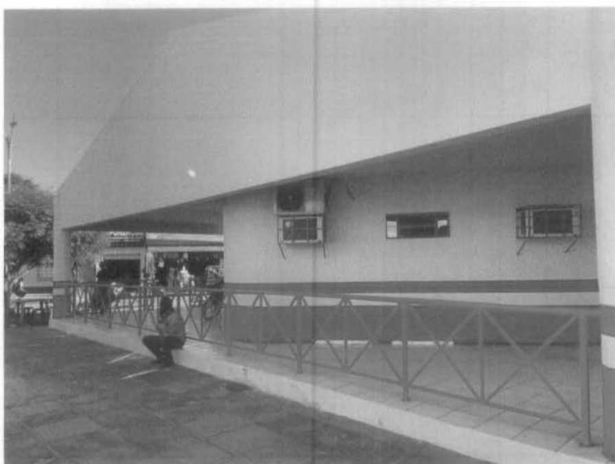
Imagem 2 – Pintura da fachada do prédio.
