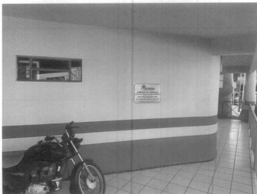
Imagem 4 – Pintura da fachada do prédio.
